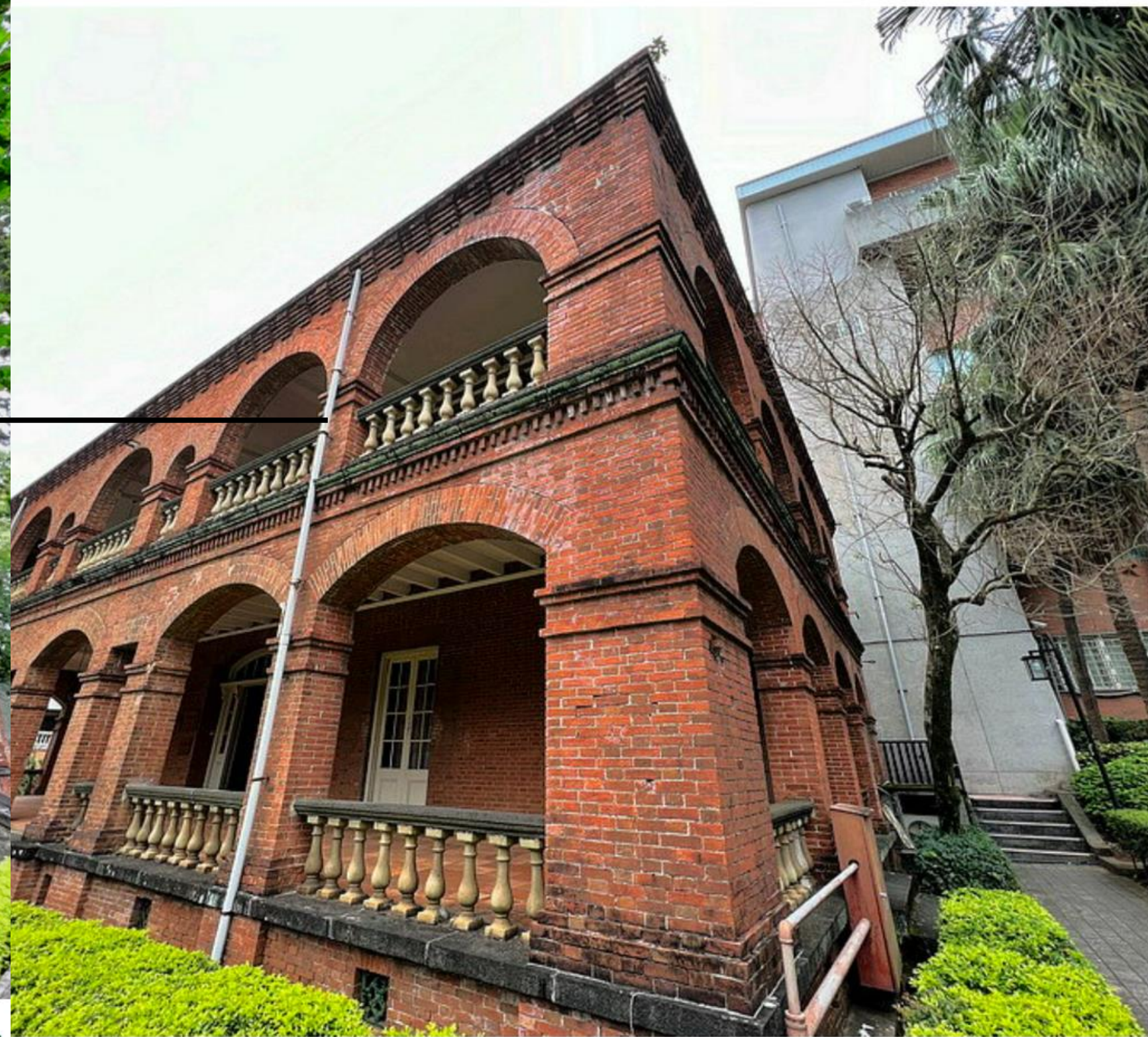
校內有兩棟紅磚洋樓，兩樓都是吳威廉牧師設計之殖民地式紅磚迴廊建築，姑娘樓建於1906年，牧師樓建於1909年。
